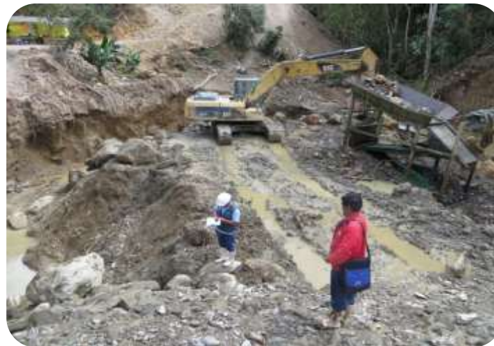
Aguas residuales minero-metalúrgicas provenientes de las actividades de minería del sector Cruz Pata.
