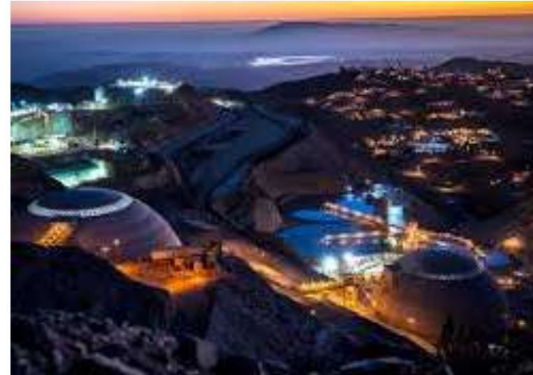
Nueva concentradora de Toquepala y campamento Plaza
