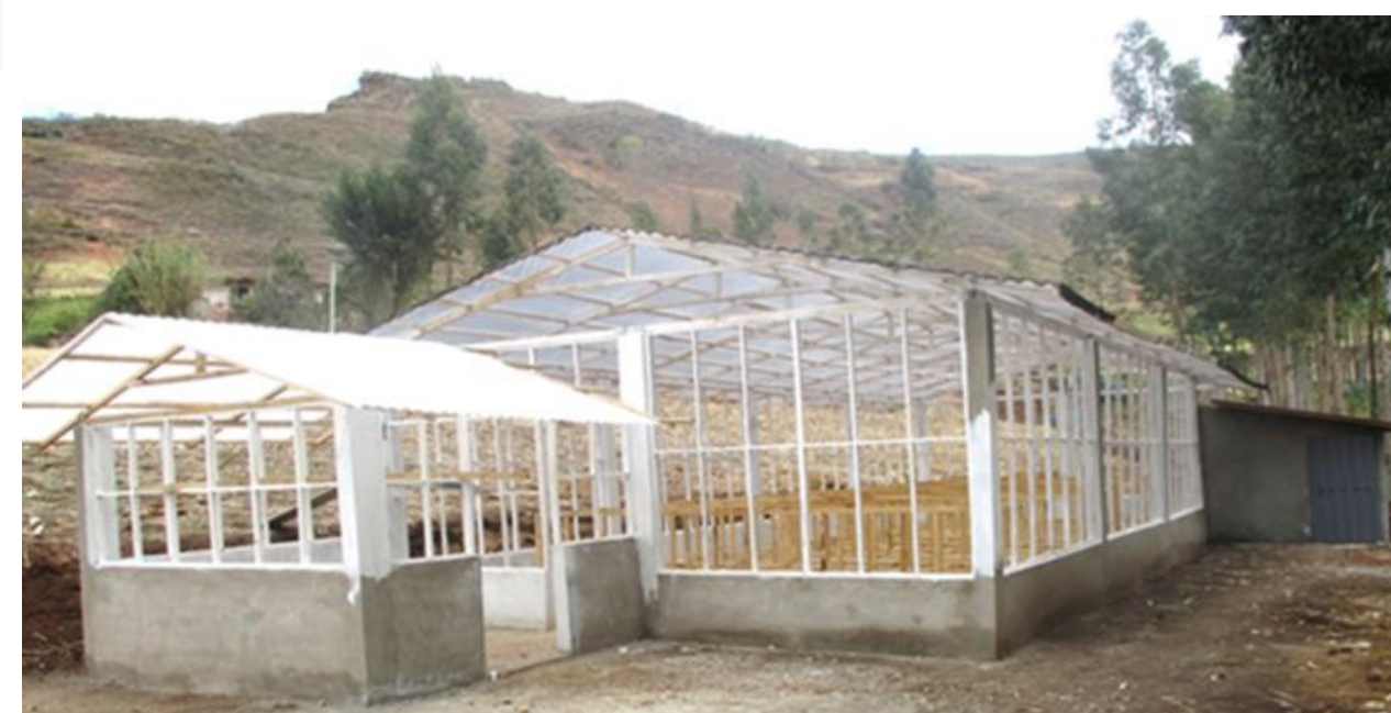
Invernadero Aeropónico para la producción de tuberculillos de papa poderosa
