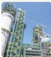
Piura (Talara) Proyecto de Modernización de la Refinería de Talara (Petroperú)
